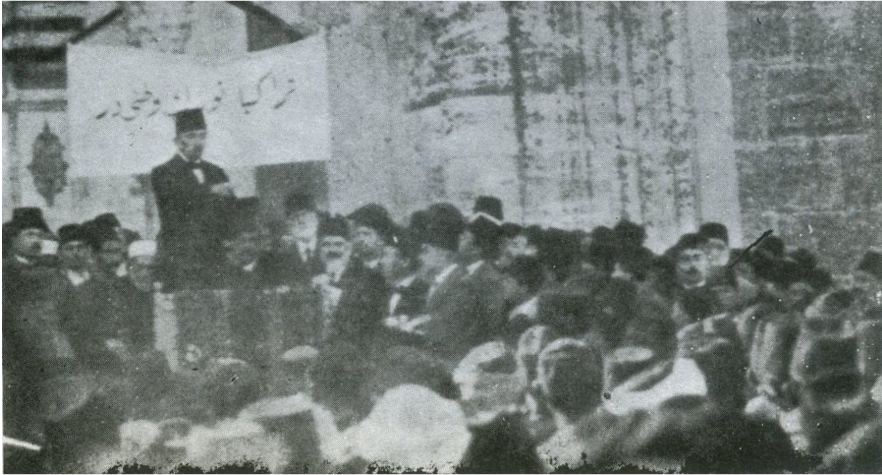
Edirne Selimiye Camiinin bahçesinde yapılan miting
